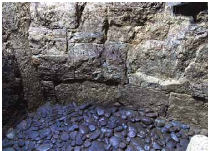
▲ 玄室西壁の切石積みと切組みのようす
